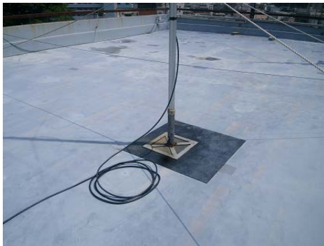
ビルの屋上に設置した基部
