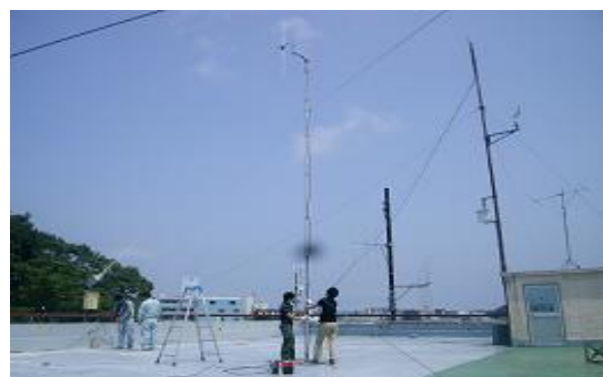
塩竈市役所屋上のアンテナ設置作業
